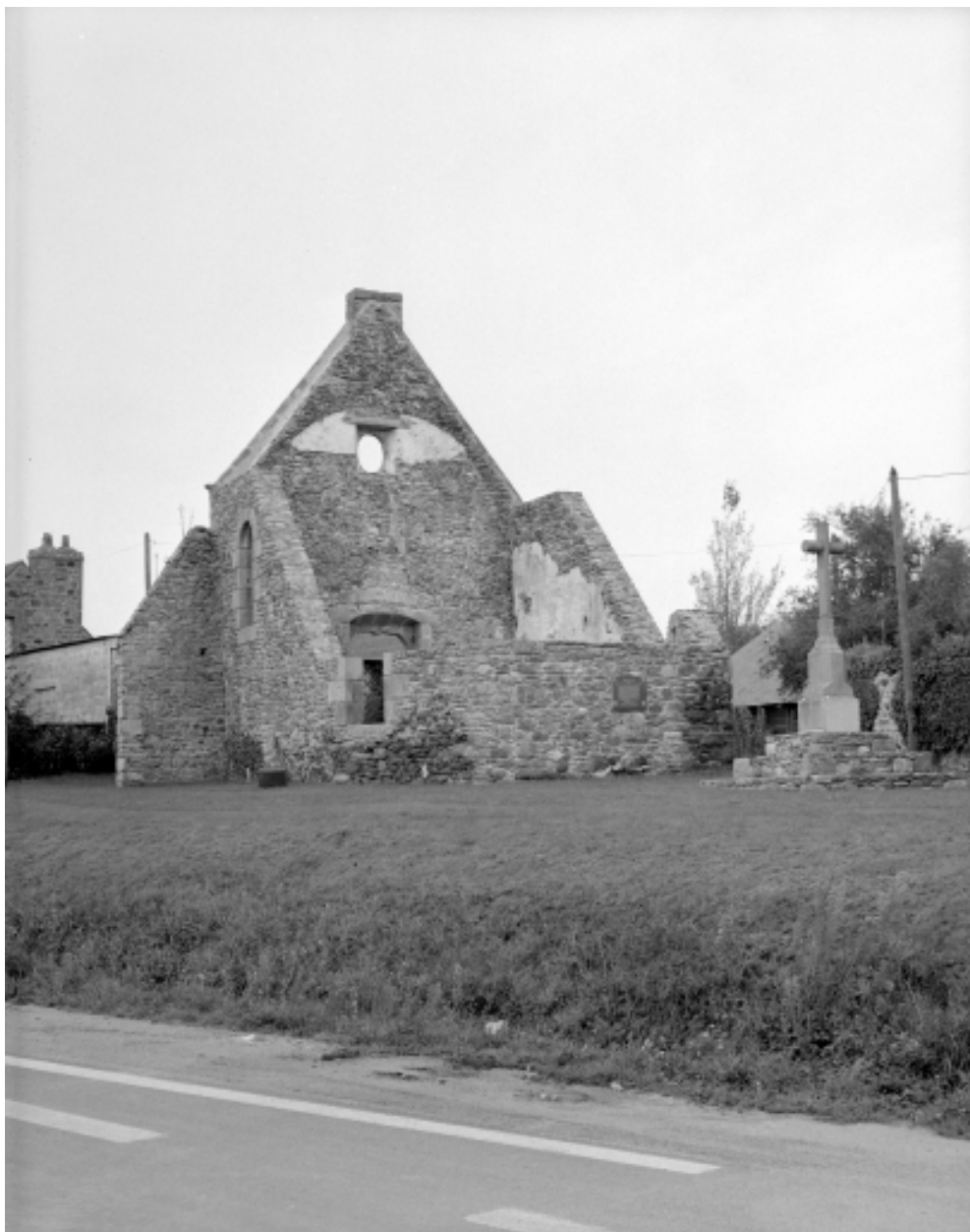
Elévation Est : vue générale
