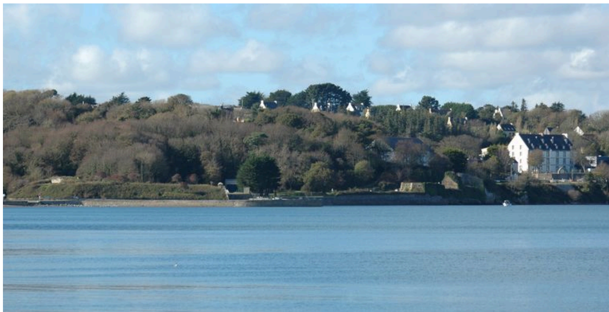
Vue générale des lignes de Quéléren au niveau de l'entrée du bourg de Roscanvel. A droite : la caserne Sourdis
