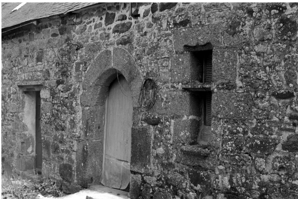
Vue de détail de la façade sud
