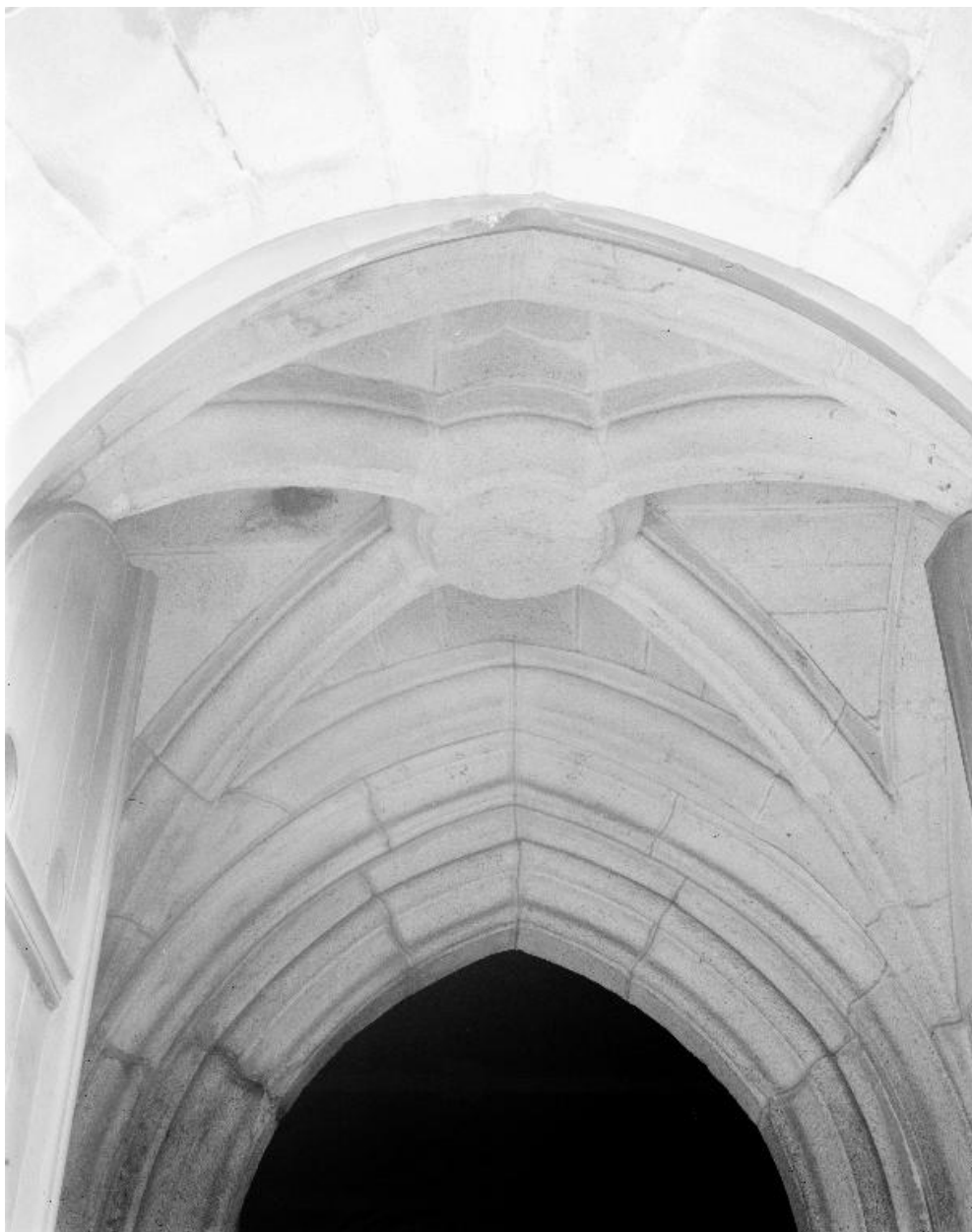
Voûte du porche sud
