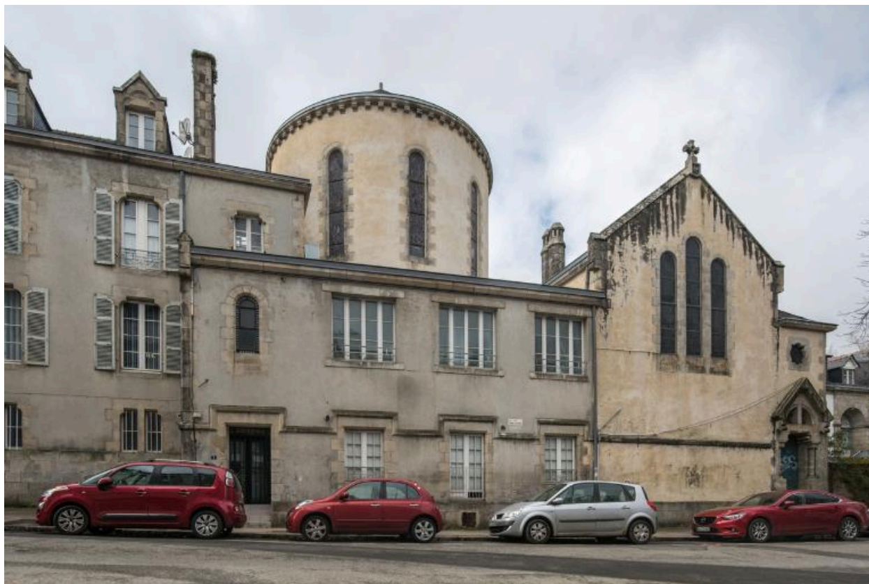
Façade sur la rue Bourg-les-Bourg et abside de la chapelle, J. Bigot architecte, 1853.
