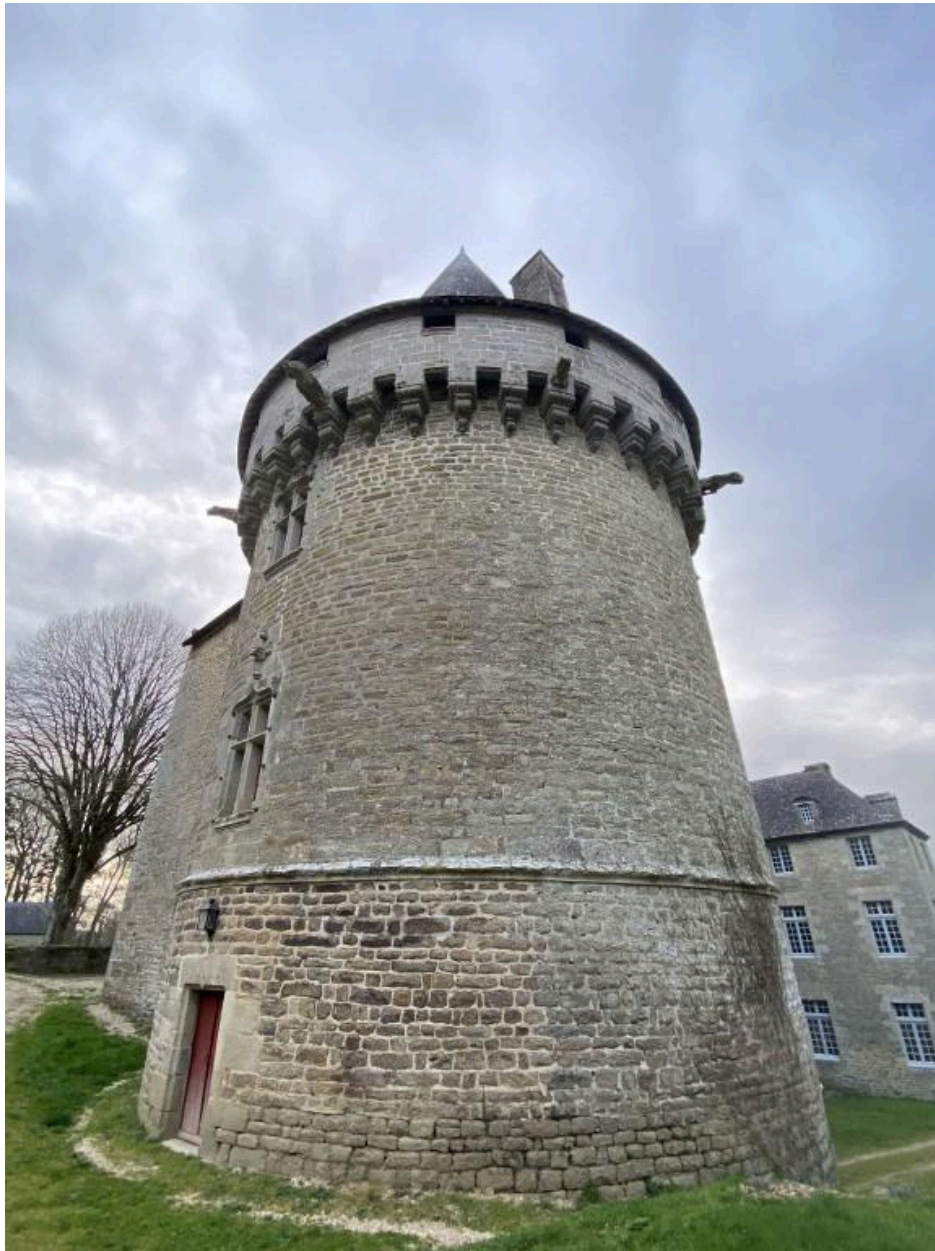
Tour sud, vue générale
