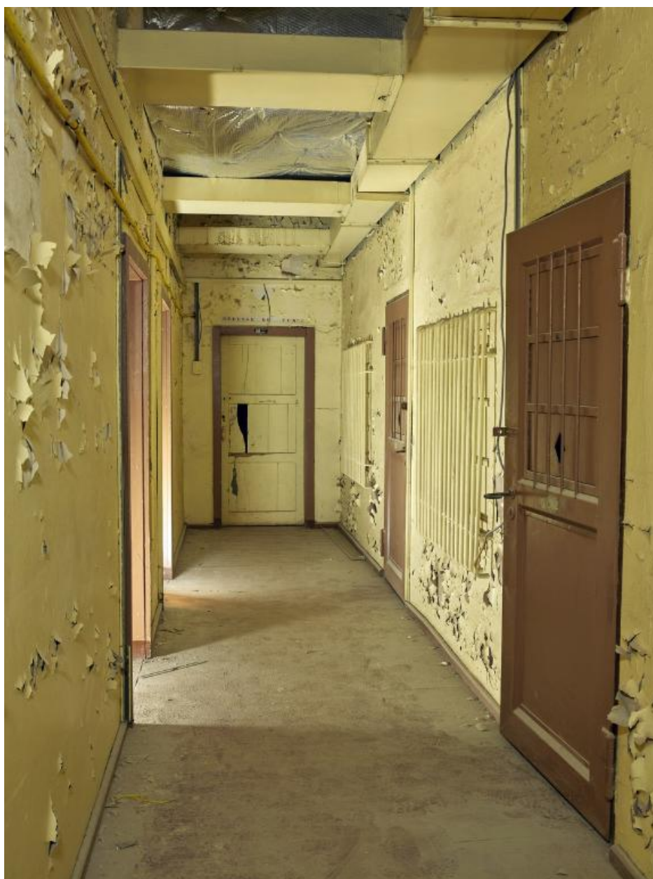
Vue du couloir du troisième étage de la nef n° 3 desservant des bureaux (en 1945). Les deux bureaux situés à droite ont été transformés en cellule (porte et fenêtre barreautées)
