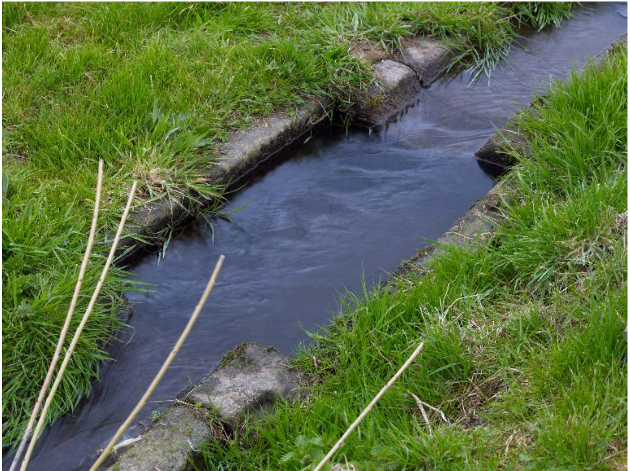
Potager. Rigole d'irrigation. Détail d'un puits perdu permettant de puiser l'eau amenée par la rigole
