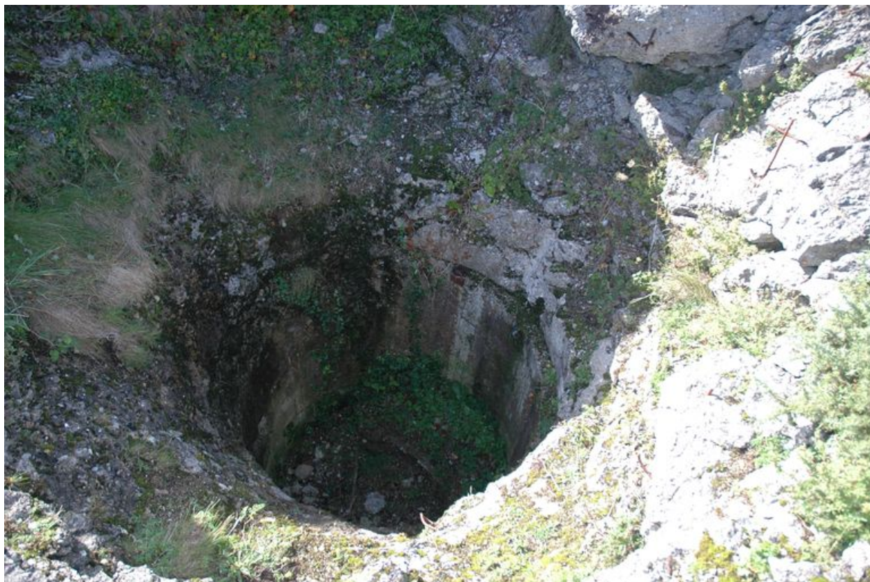
Vue de l'emplacement de la cloche blindée. Détail du puits
