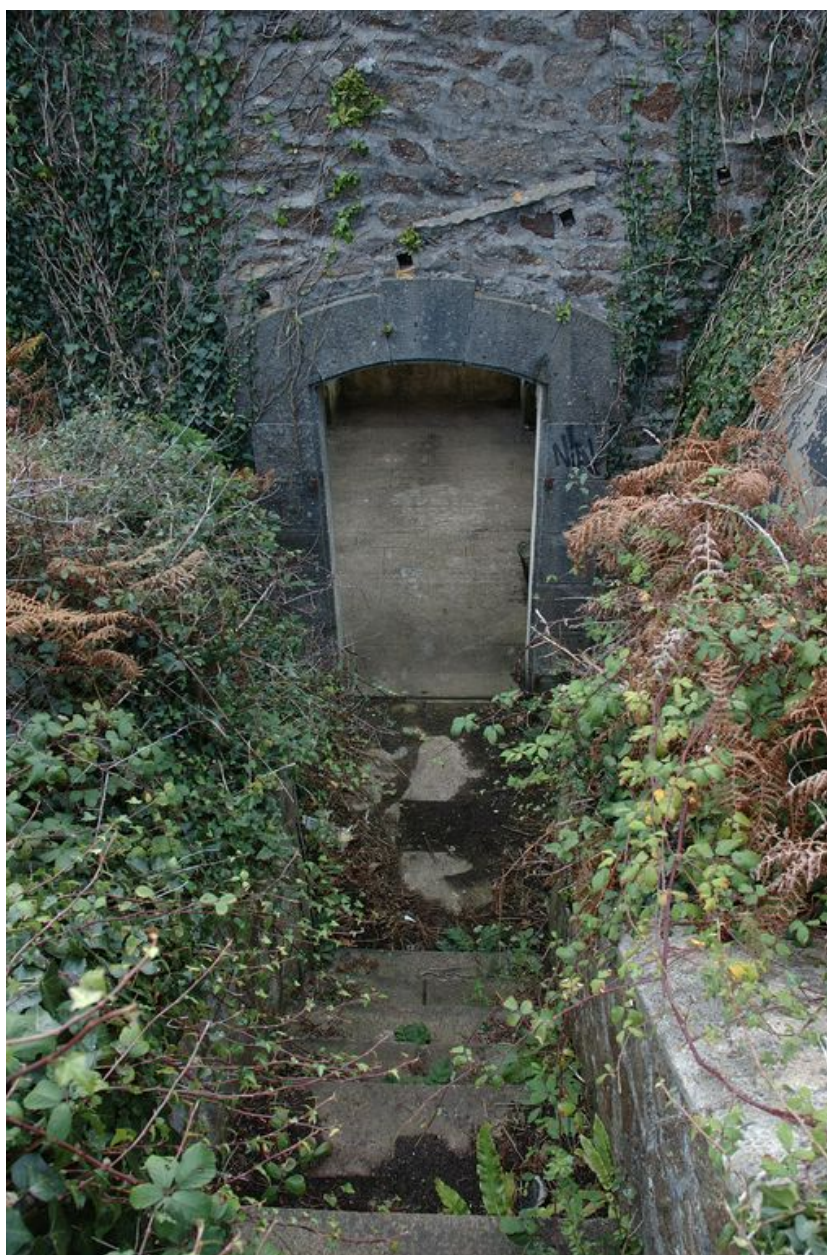
Vue des casemates de projecteur : entrée (état en 2007)
