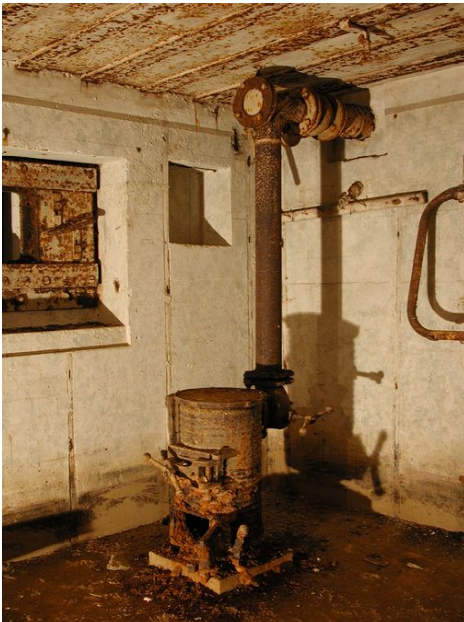
Vue du poêle de type Wt80K à plaque pour réchauffer les plats (chambre de troupe gauche)
