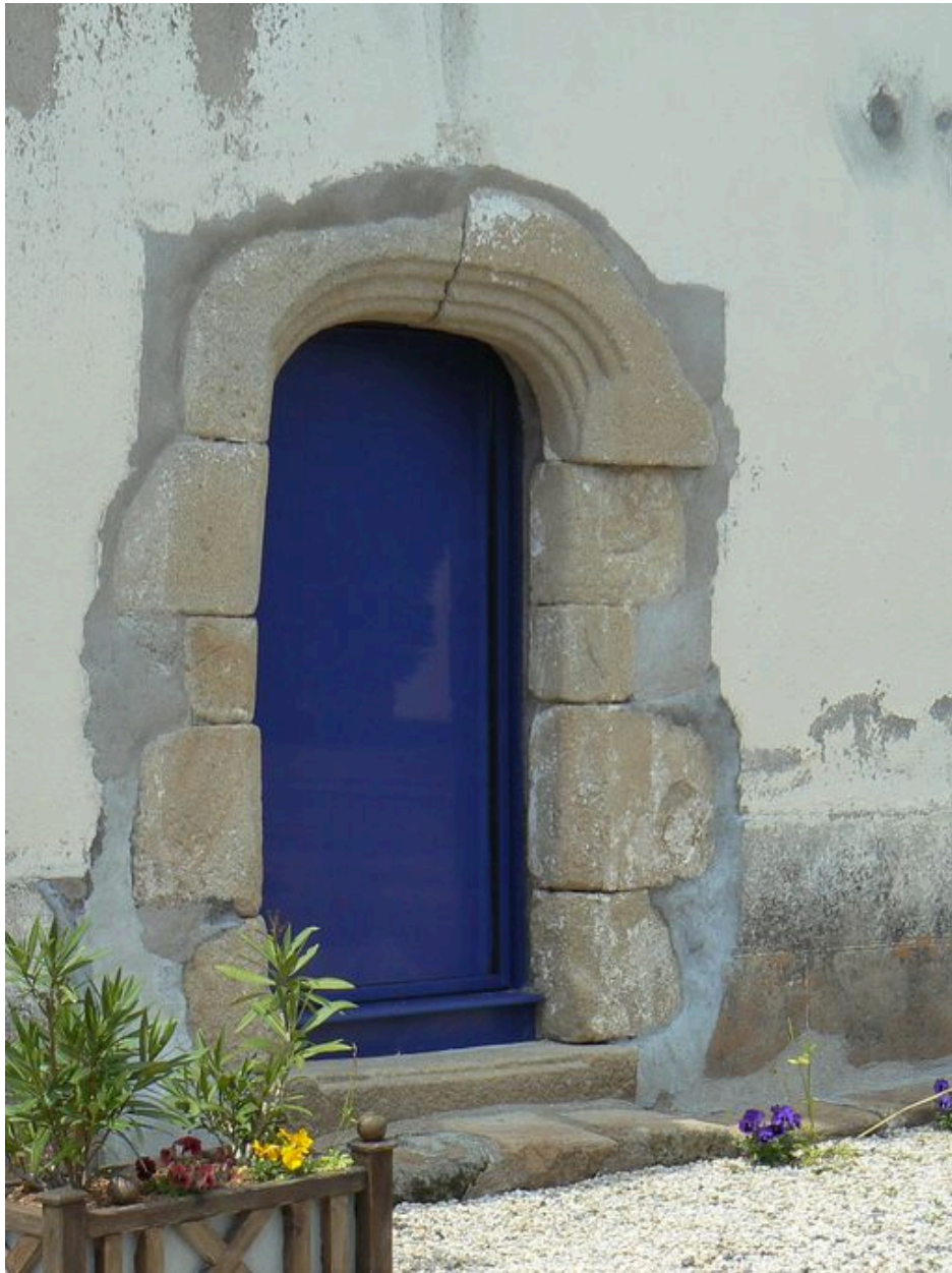
Porte de la maison du 2 rue des Algues
