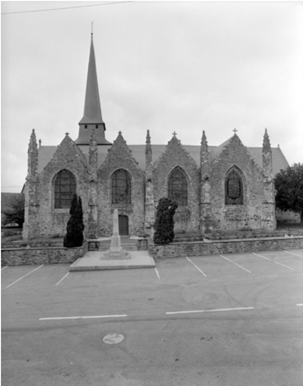
Façade sud de l'église
