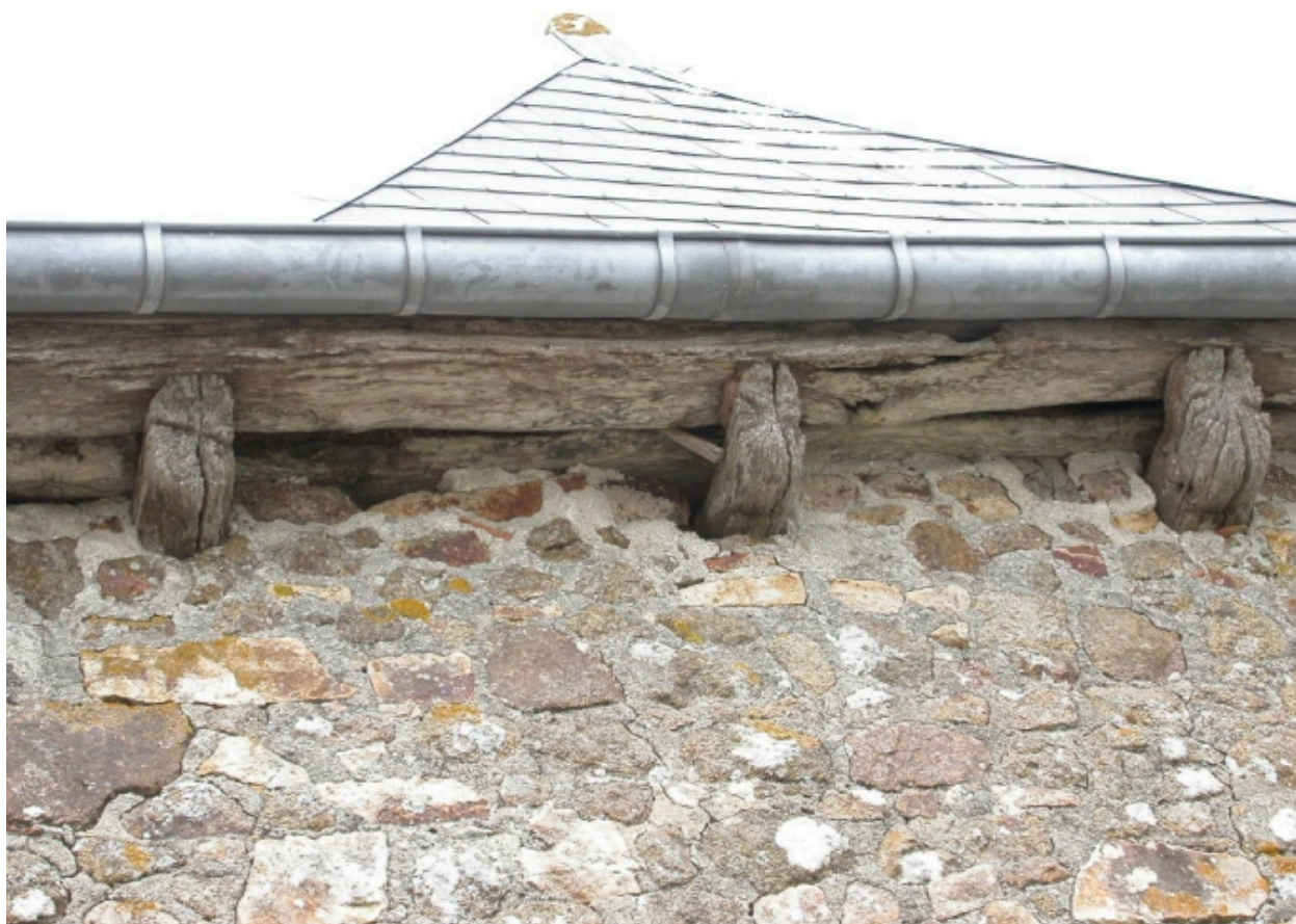
Détail de la corniche
