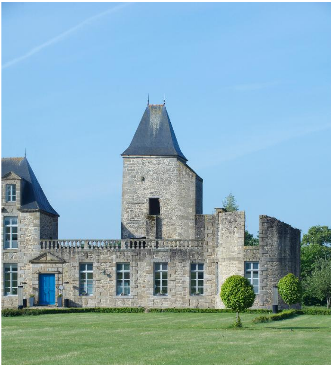
Vue sur la tour d'escalier
