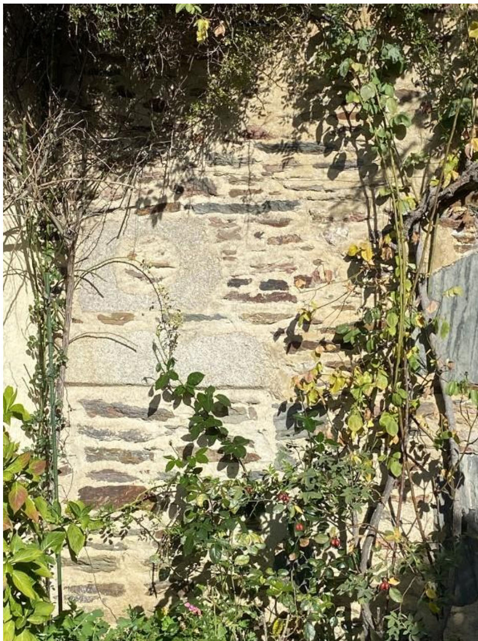
Porte murée, vue sud
