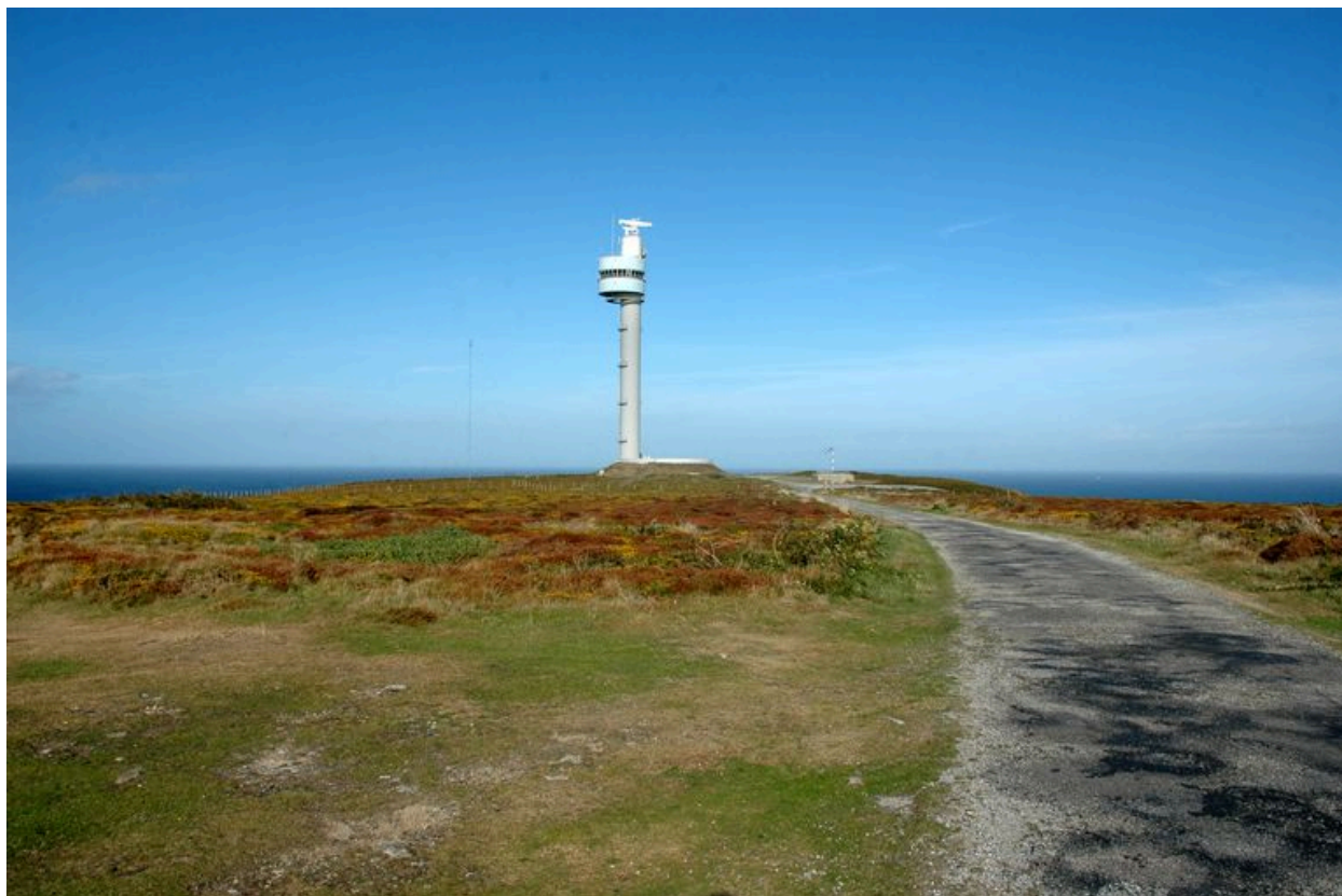
Vue de situation (état en 2005)
