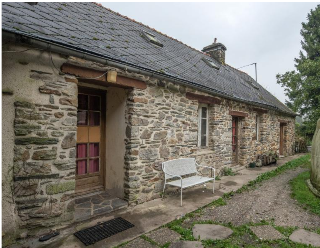
Maison de blanchisseurs, 18e siècle. Vue sud-est
