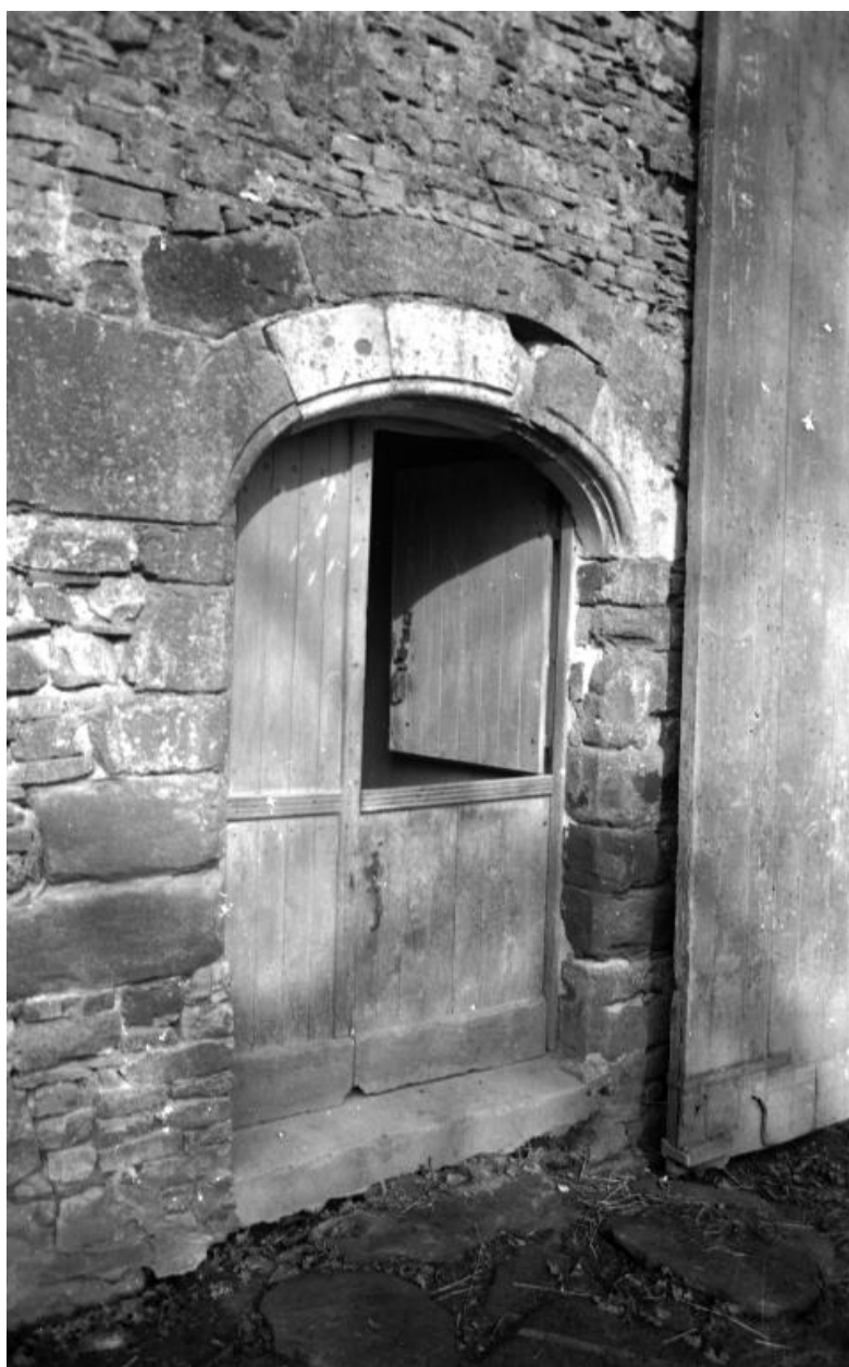
Porte de communs, vue de détail.
