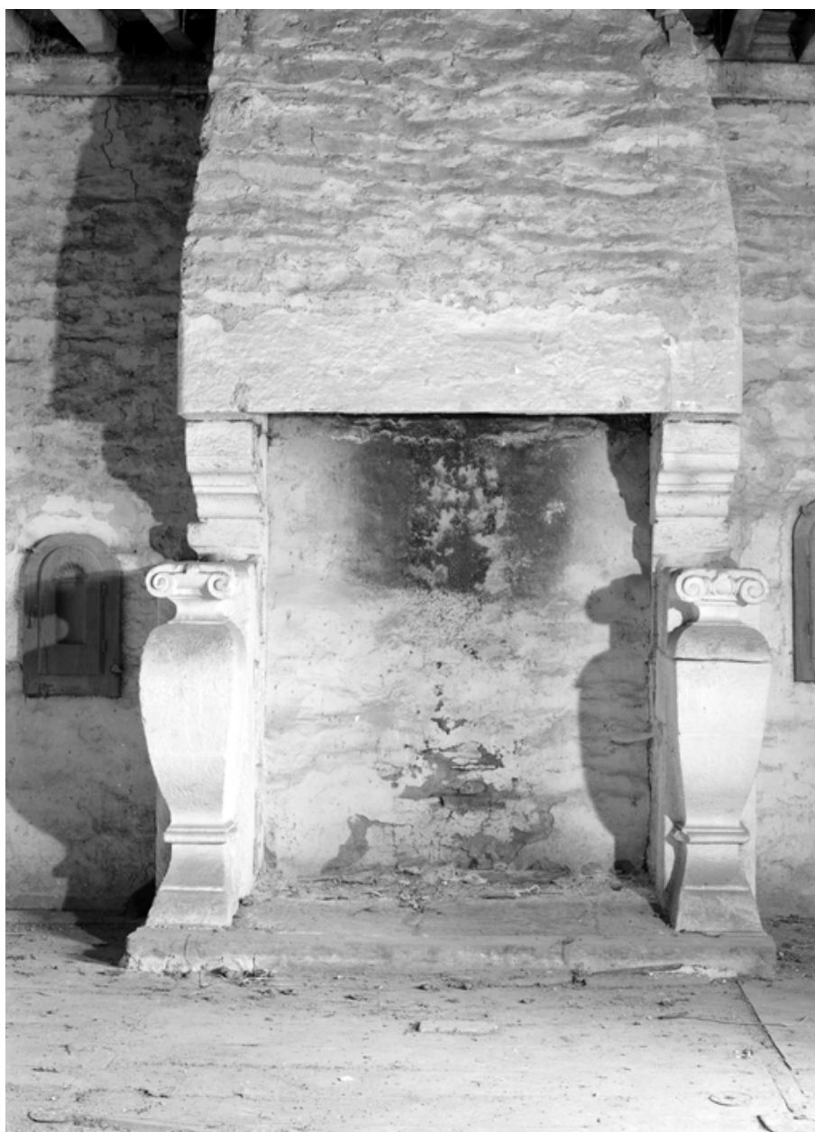
Corps de logis : cheminée de la 2e salle du 1er étage
