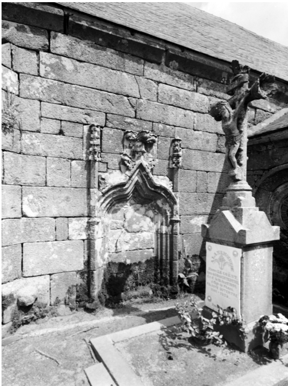
Porte du mur ouest du bras nord du transept
