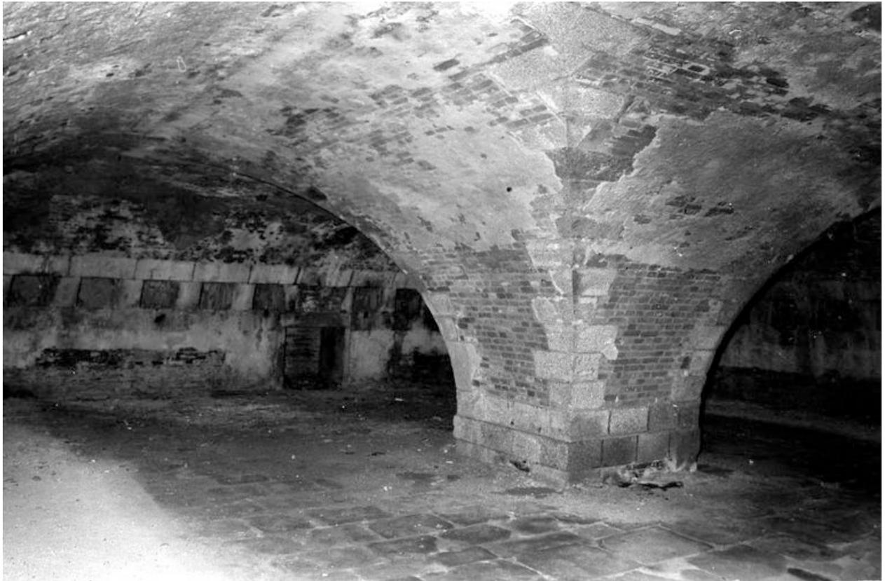
Vue de la tour-modèle n° 1 type 1811 de la pointe de Cornouaille en 1969 : deuxième niveau percé de créneaux de fusillade, pilier central, cheminée
