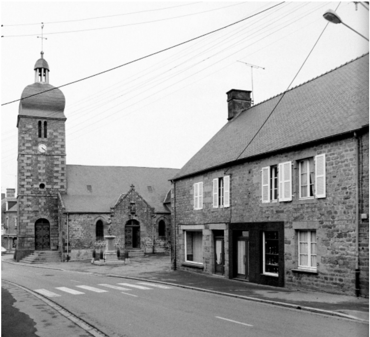
Elévation Sud, partie Ouest : vue générale
