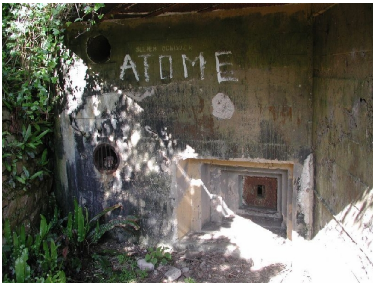
Façade de l'abri du groupe de combat affecté aux radars : postes de tir en enfilade
