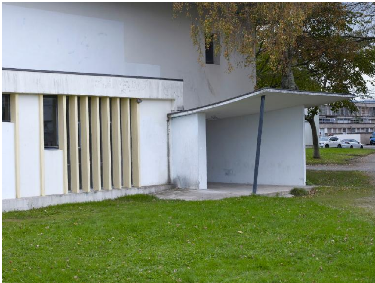
Détail de la façade et entrée. René Ouvré architecte (1966-1967).
