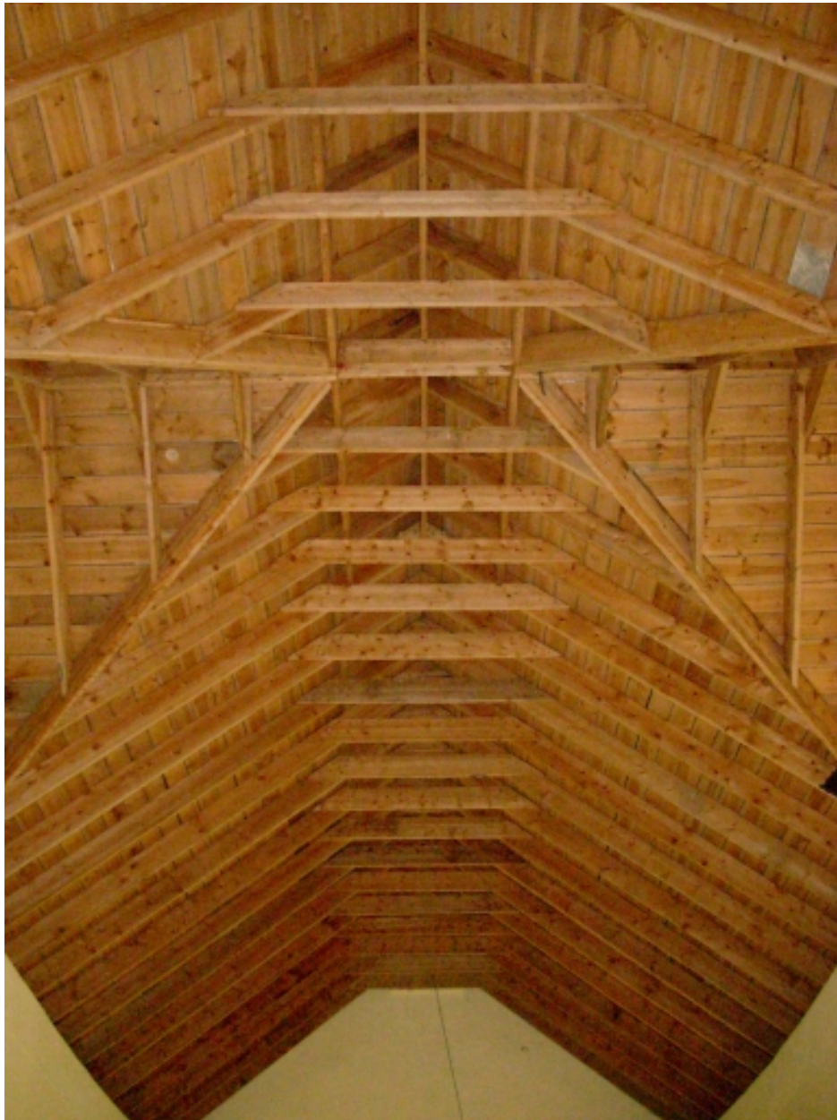
Locmaria-Plouzané, chapelle Saint-Sébastien : détail charpente en bois apparente
