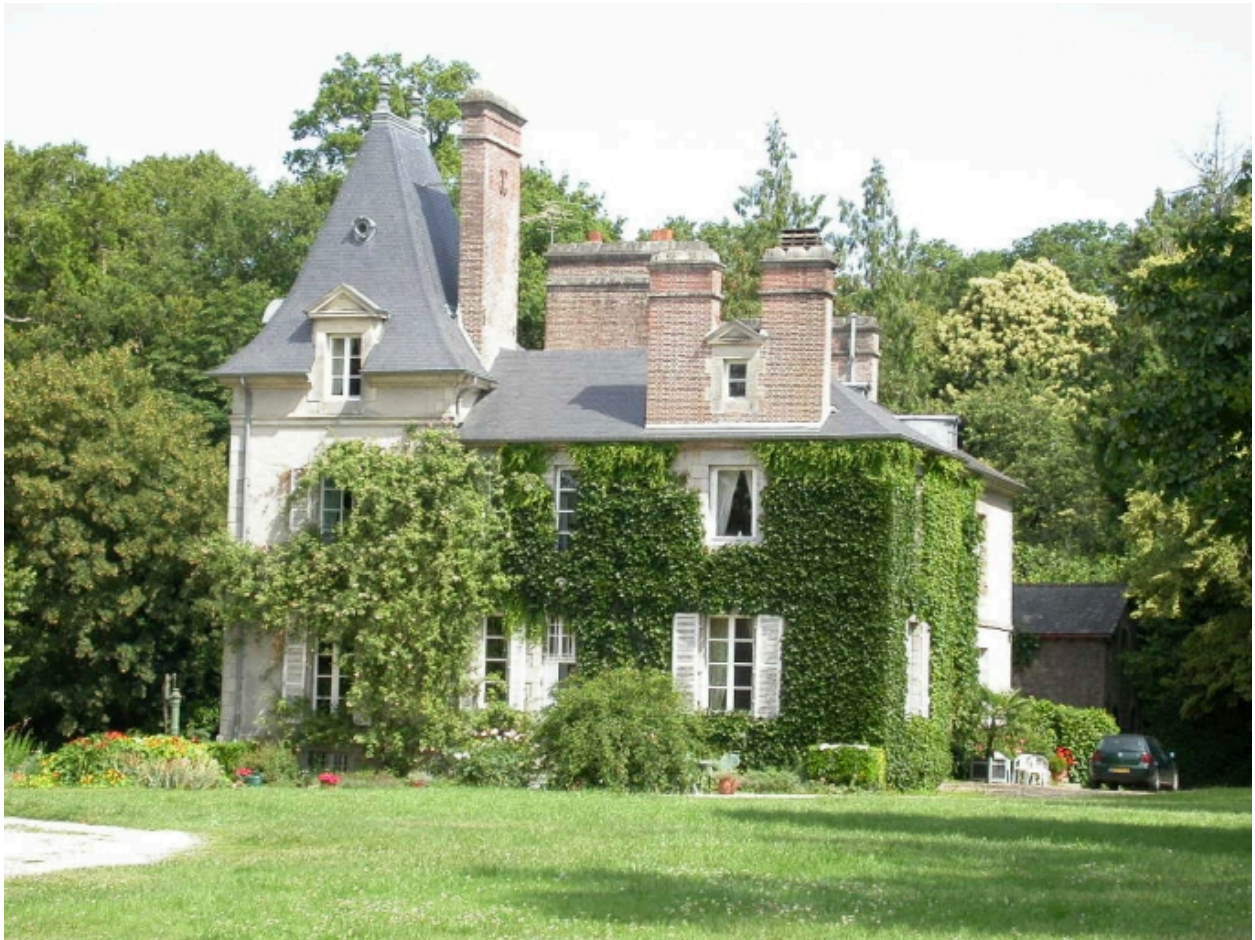
Vue générale sud
