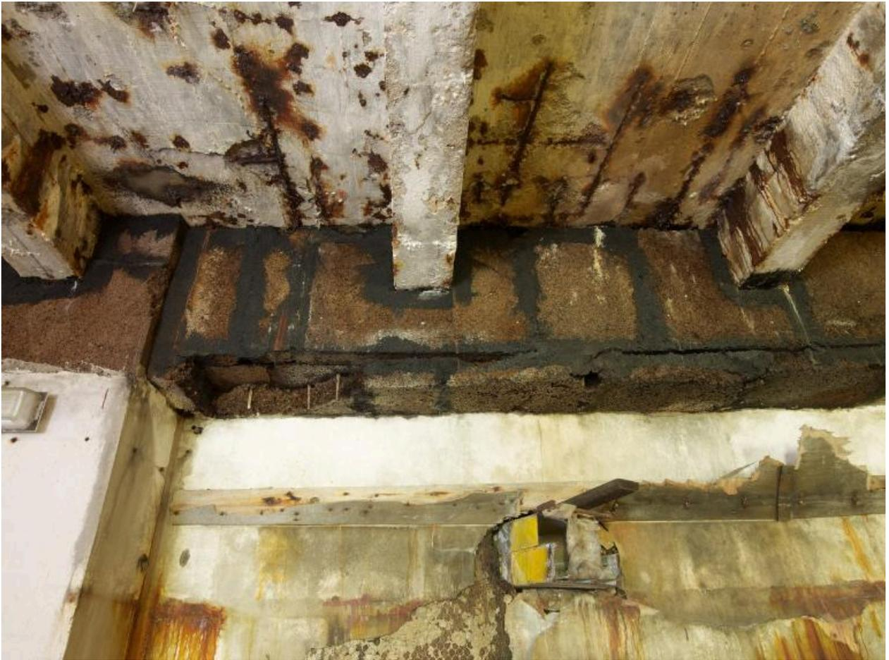
Frigorifique de Lorient : isolant en liège
