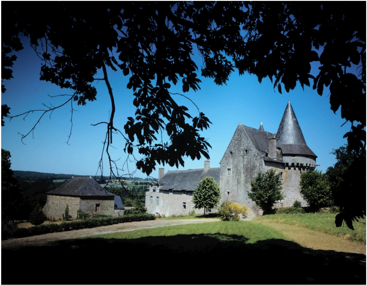
Vue générale prise du sud-ouest (état en 1988)
