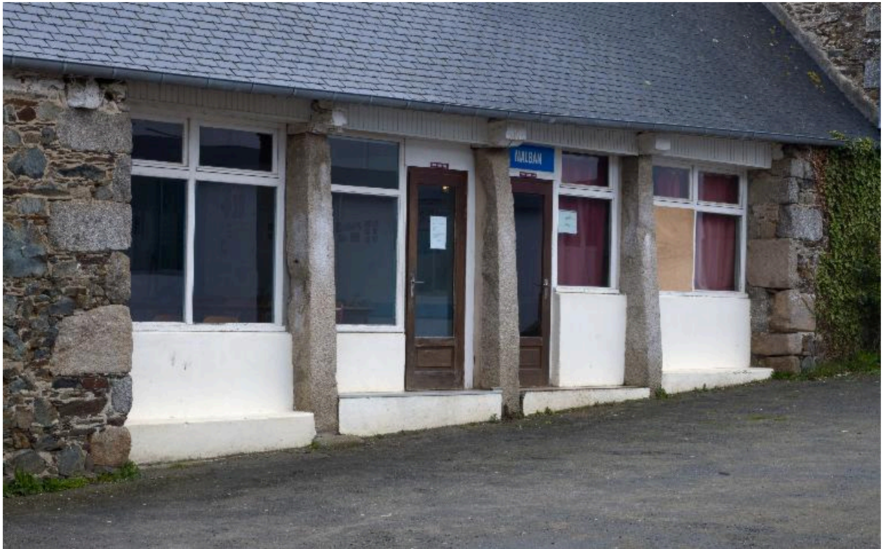
Remise agricole au nord-est du château. Détail du mur ouvert soutenu par trois piles monolithes
