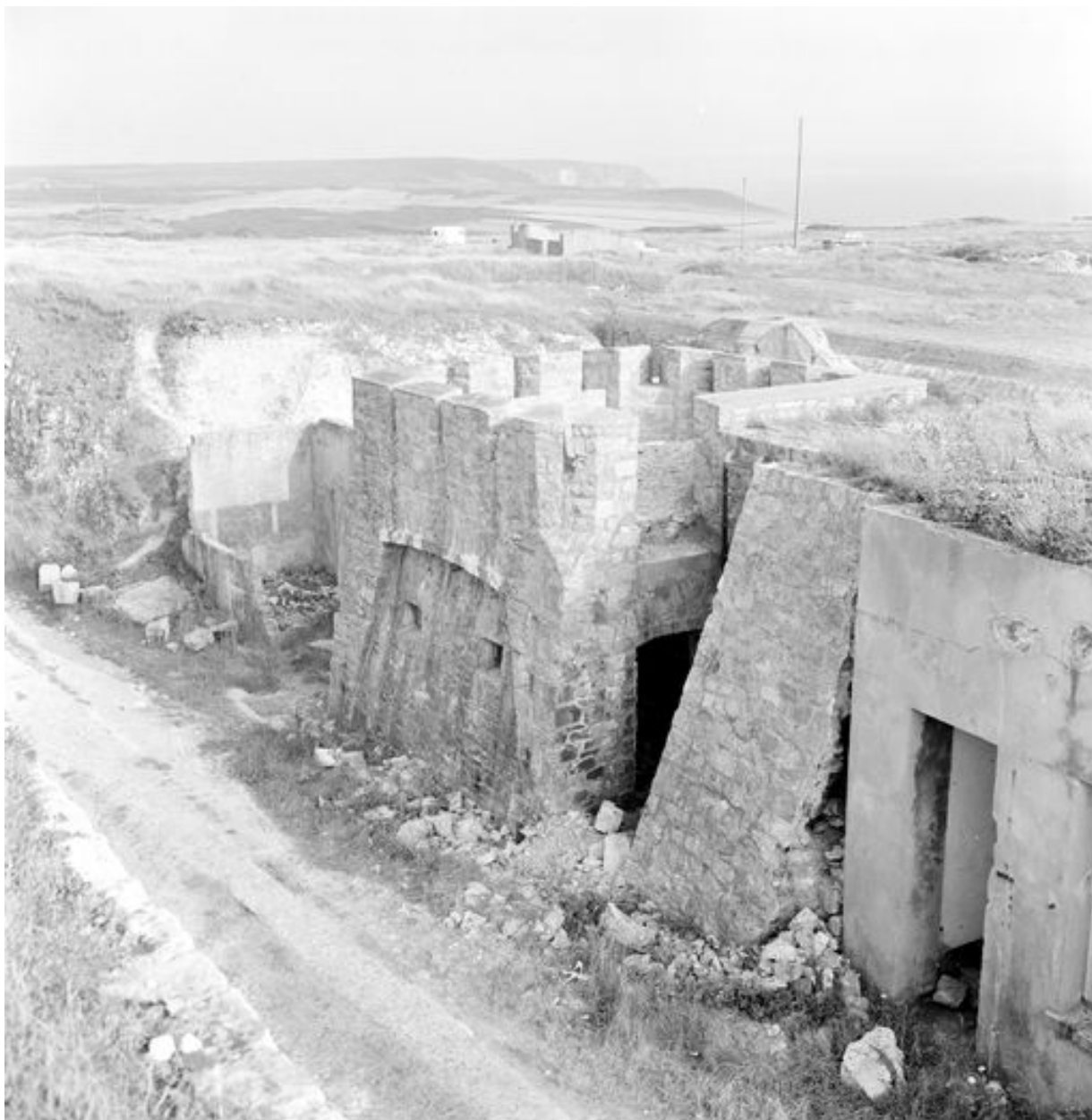
Vue de la batterie de Kerbonn en 1969 : tour de défense faisant caponnière de gorge flanquant le fossé (branche sud) et battant la route d'accès
