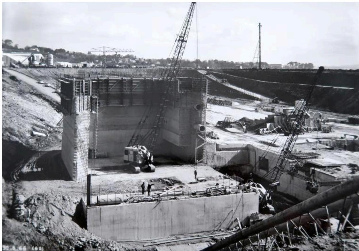
Travaux de construction de la forme 2 : radier et station de pompage (30/03/1966)
