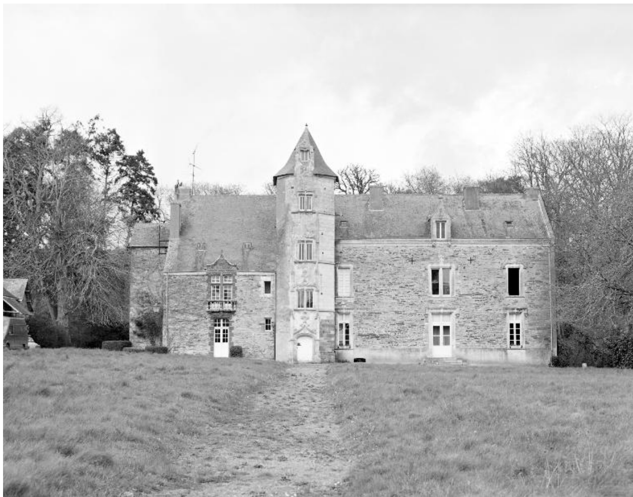
Élévation sud : vue générale
