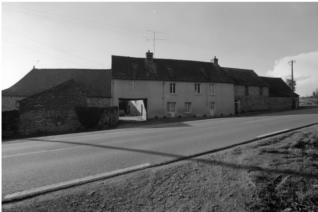
Vue générale est.
