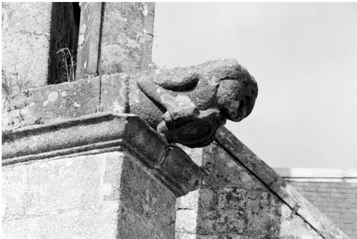
Contrefort nord est du chevet, détail : gargouille
