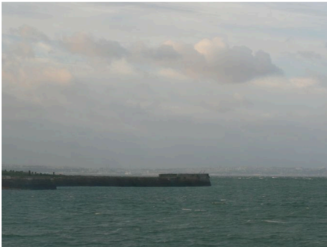
Vue de la cale de l'île des Morts
