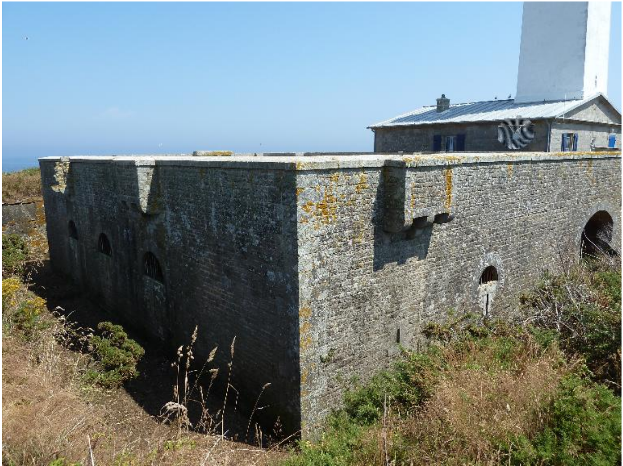
Archipel de Glénan, batterie de Penfret, corps de garde crénelé, façades nord et ouest.
