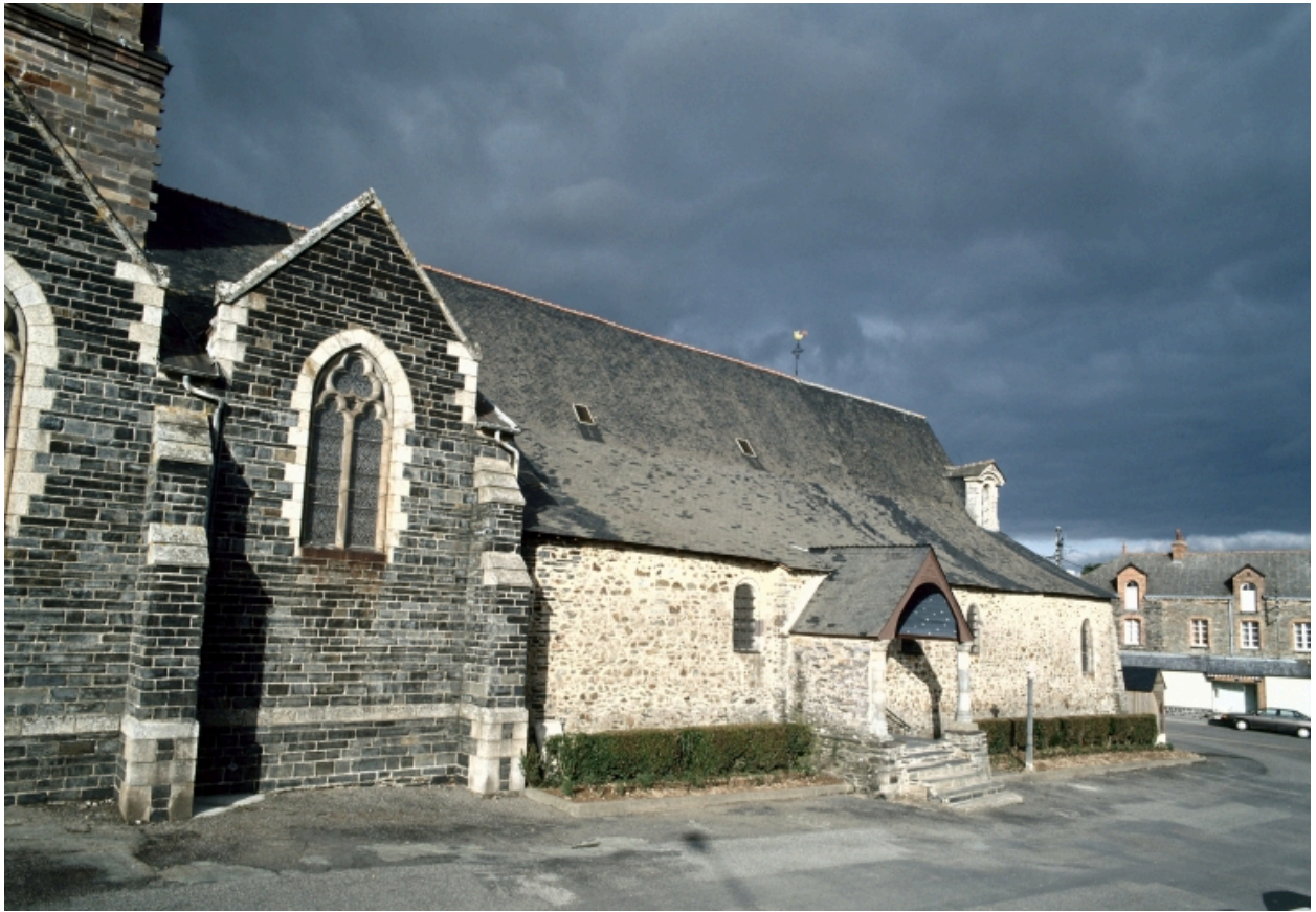
Elévation Sud-Ouest : vue générale
