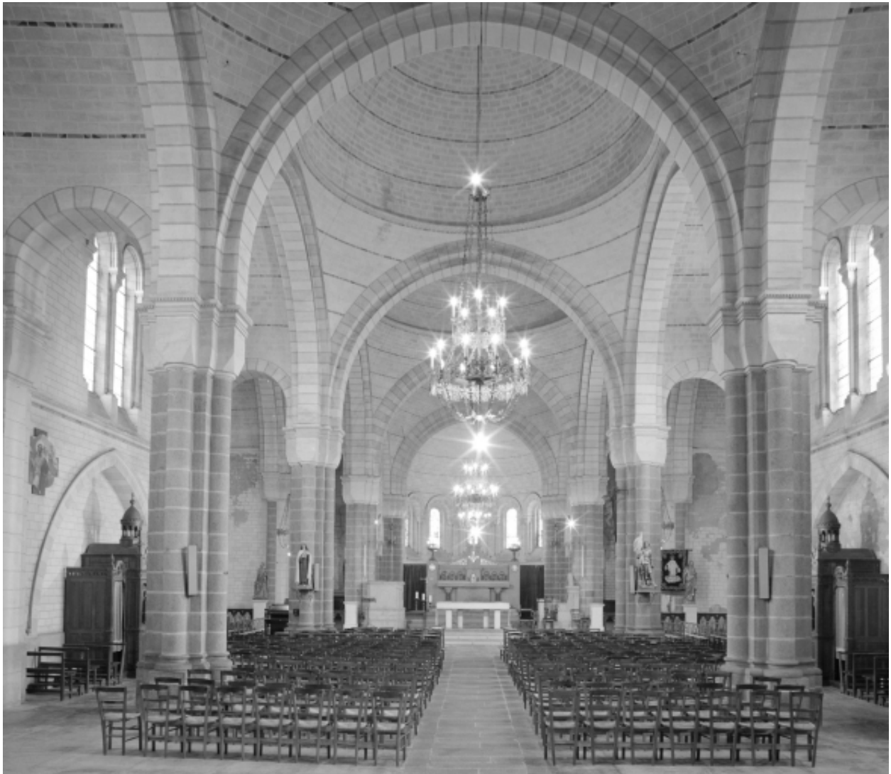
Intérieur : vue générale vers le chœur.
