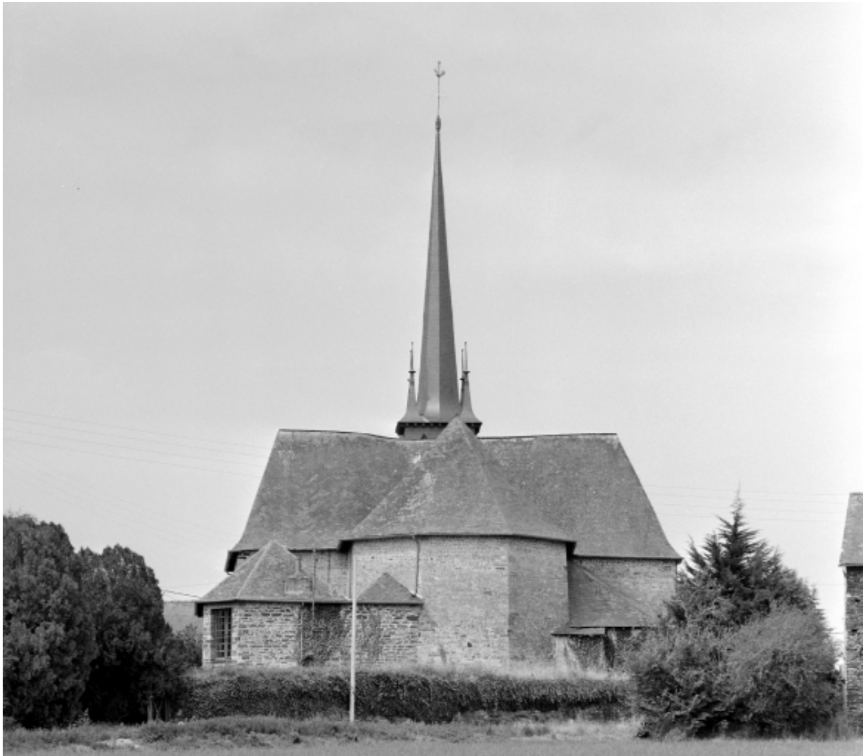
Elévation est : vue générale
