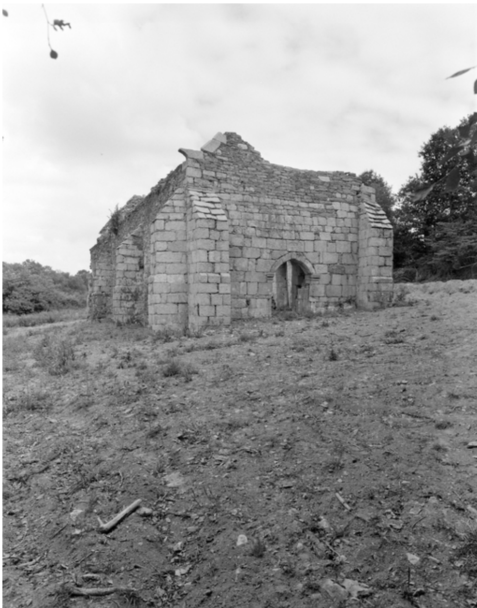
Vue générale de la façade ouest
