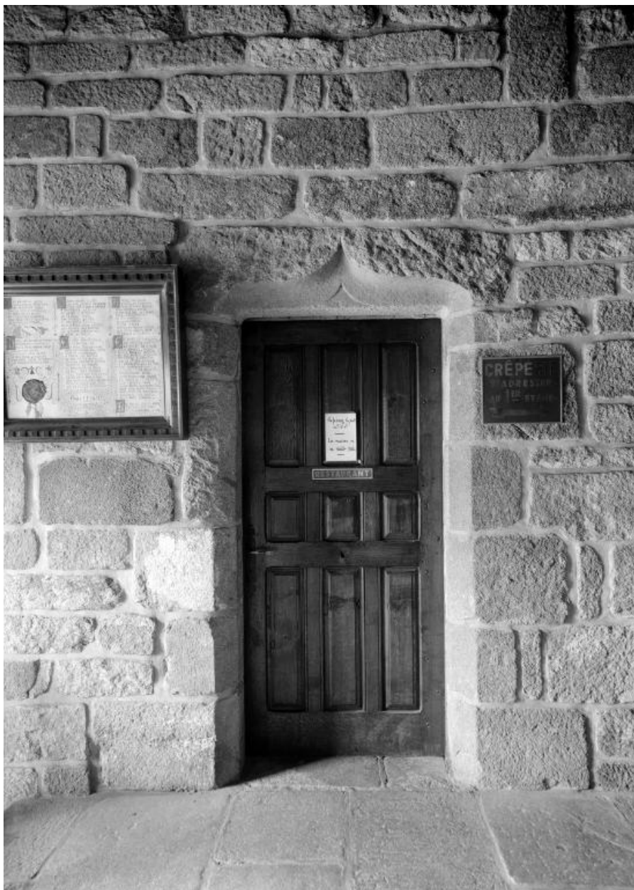
Couloir d'entrée, porte sur le mur de refend ouest
