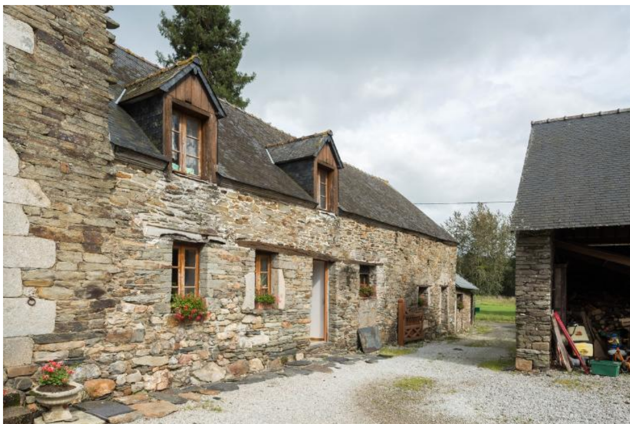
Logis-étable fin 18e ou début 19e siècle. Vue générale sud-ouest
