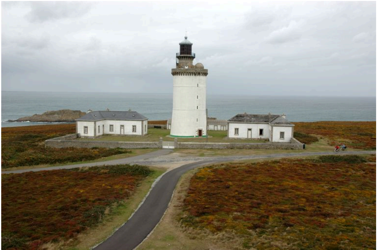
Vue générale du phare du Stiff
