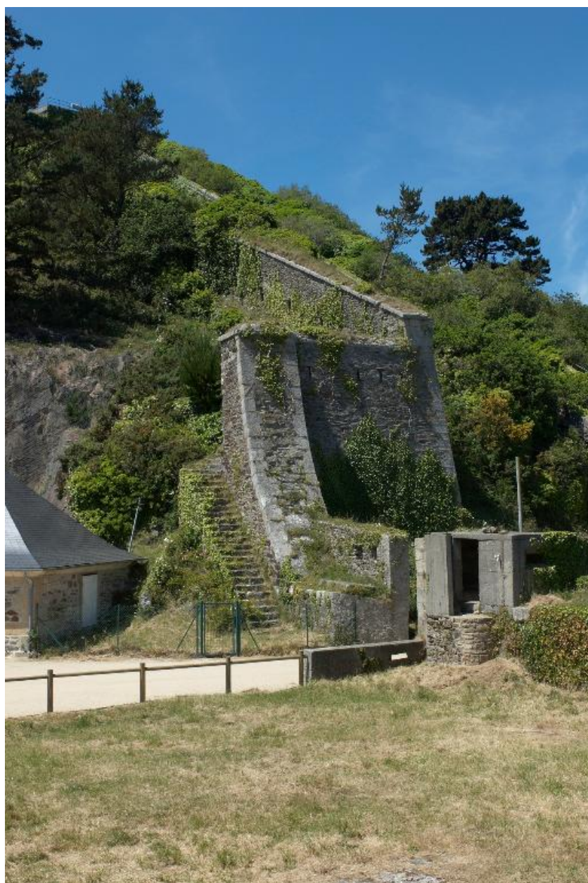
Plouzané : vue du fort du Mengant, mur d'enceinte dit branche tombante est percée de créneaux de mousqueterie et escalier parallèle
