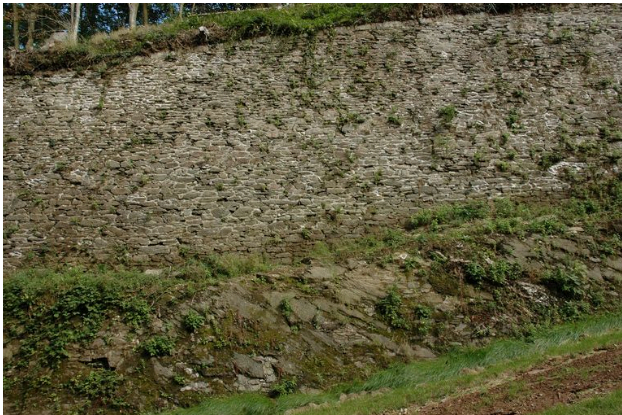
Vue de l'ouvrage à cornes de Quéliverzan : escarpe ancré sur le rocher
