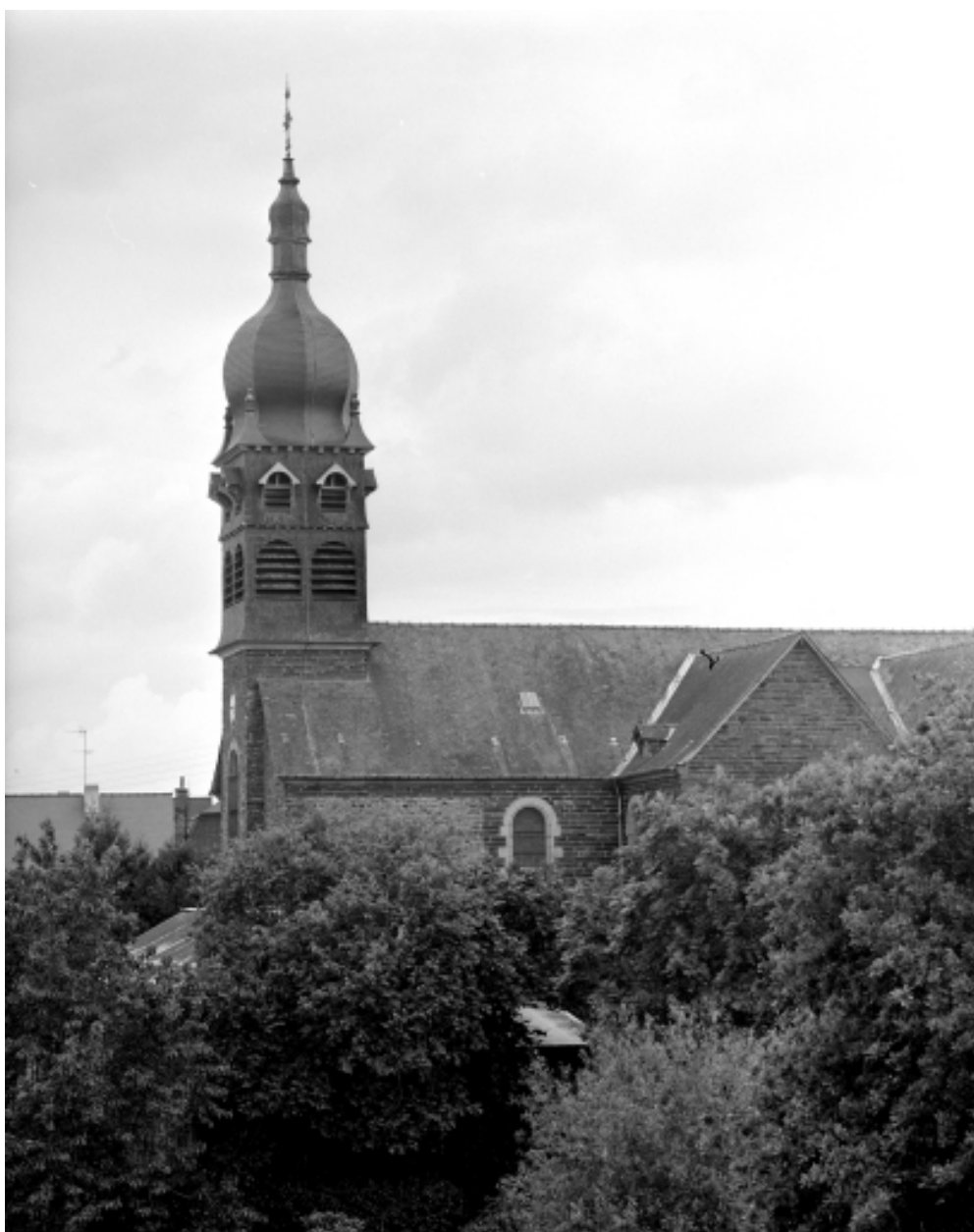
Elévation Sud, partie Ouest : vue générale
