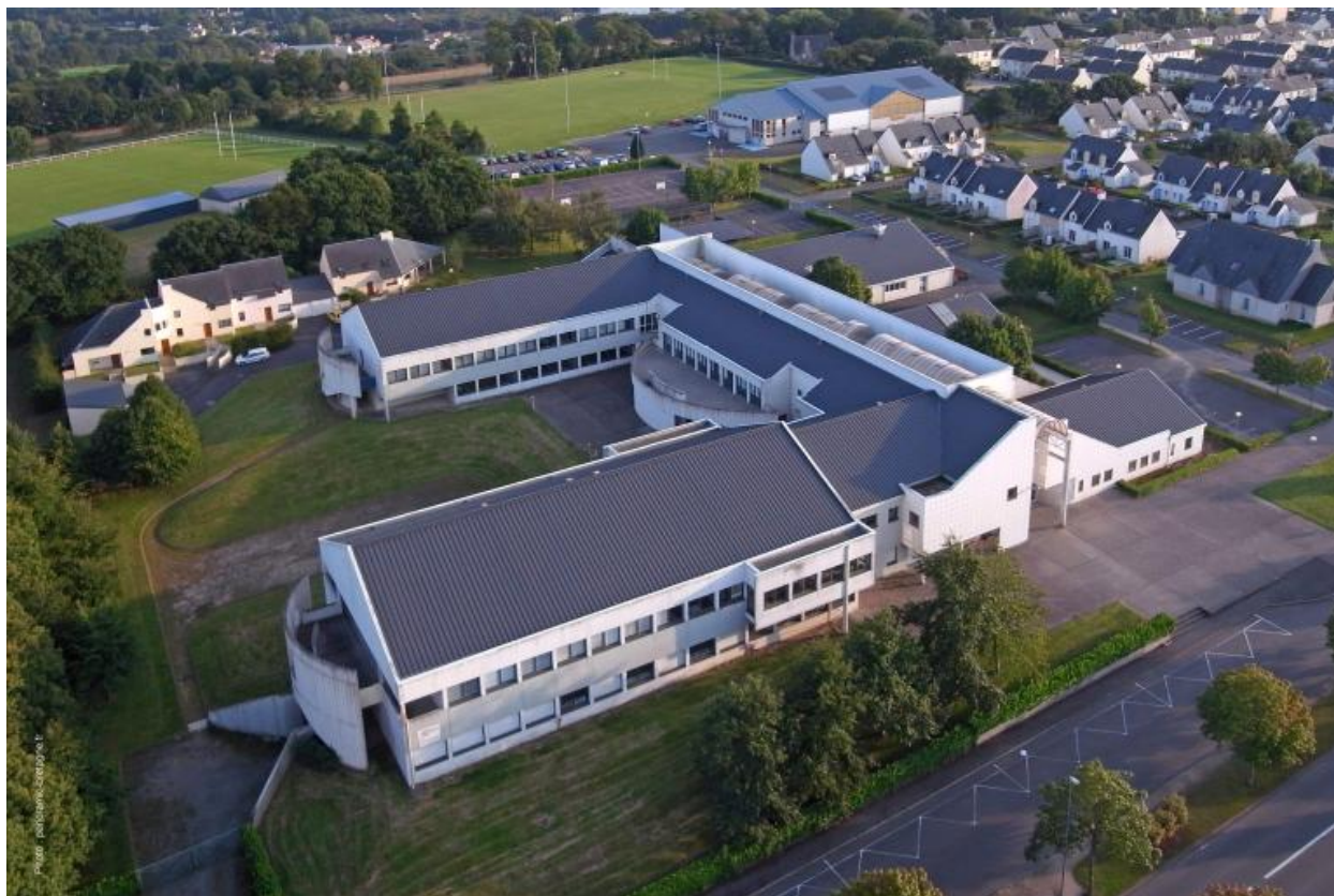
Vue aérienne oblique prise depuis le nord.
