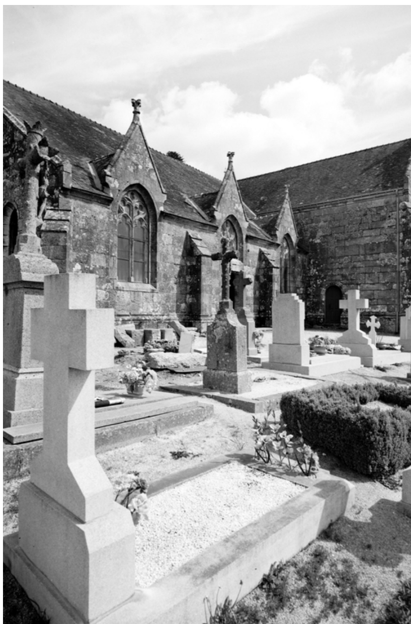
Vue générale façade sud
