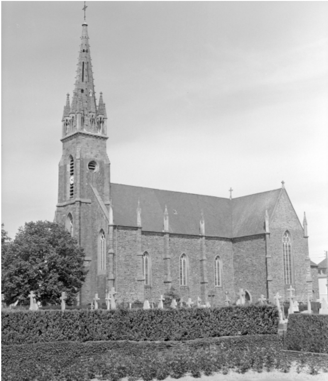
Elévation Sud-Ouest : vue générale
